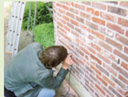
Onderzoek ter plekke van de spouw
